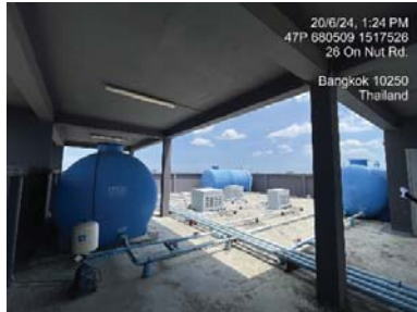
รูปที่ 14 ถังสำรองน้ำชั้นดาดฟ้า
